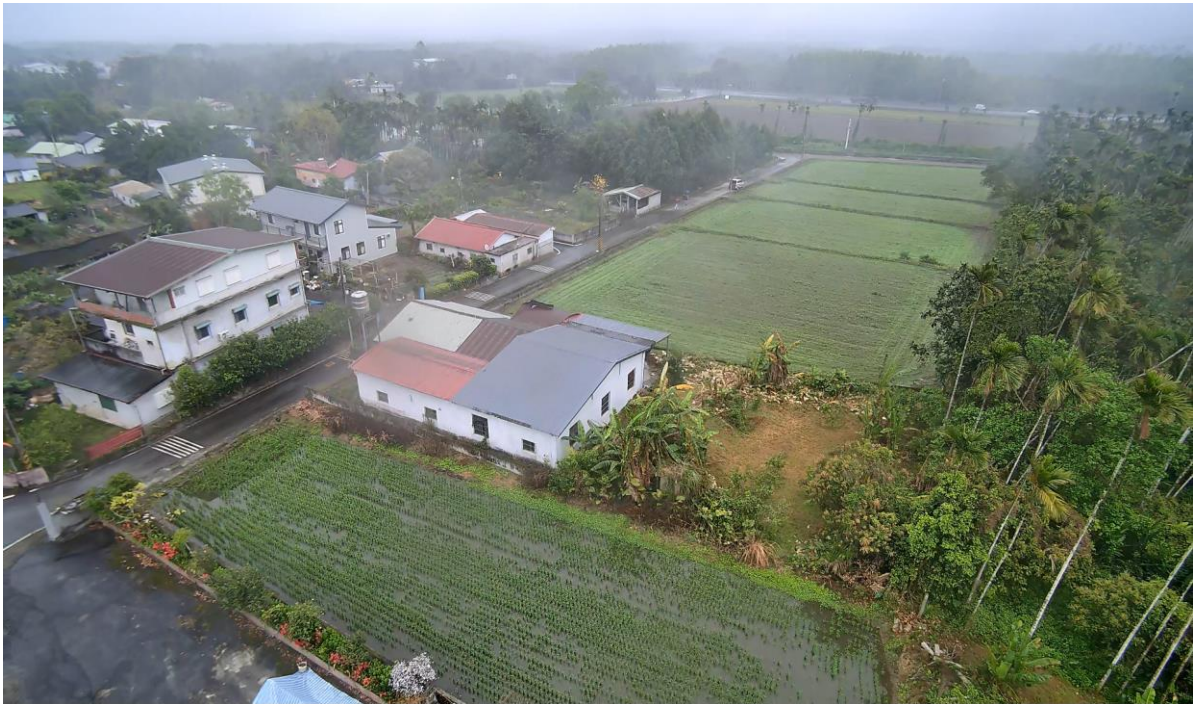
(花蓮縣光復鄉大豐村尚德街建物及其坐落基地)
