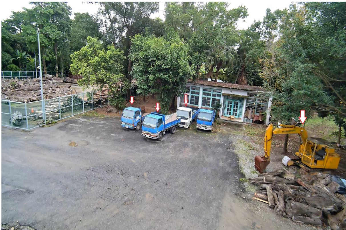
(3 台貨車與 1 台挖土機空拍畫面)
